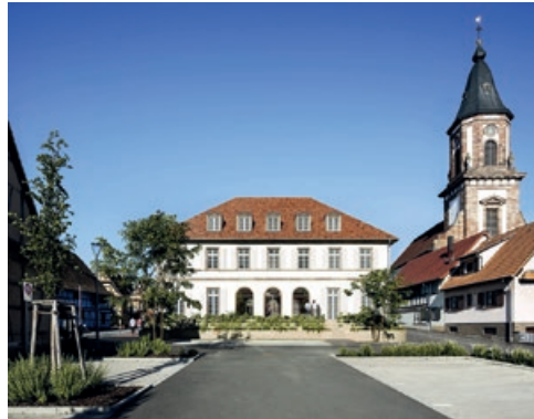
La façade patrimoniale est restaurée et prolongée par un gradin végétalisé © Scherrer & Boetsch Architectes
