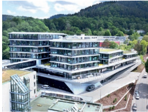
SWR Medienzentrum Baden-Baden, 2024 © Wurm + Wurm Architekten Ingenieure GmbH
