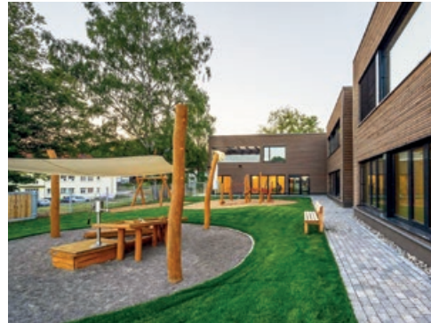
KIGA Alemannen Westfassade Garten, 2020 © Heinz Brunse
