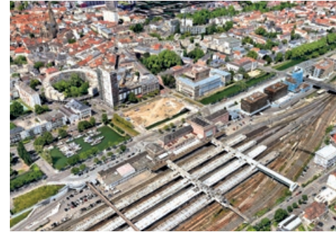
Vue aérienne de la gare © GoogleEarth
