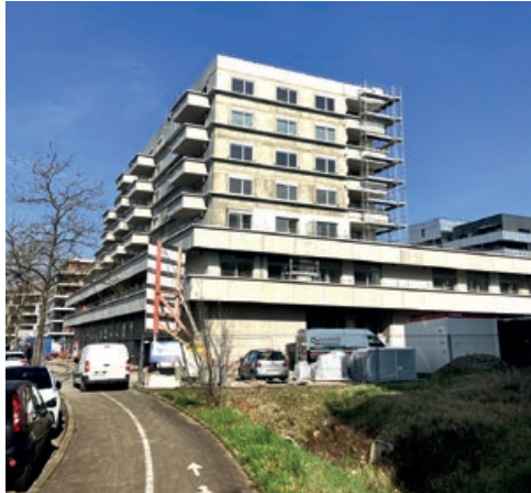
Photo du chantier © DWPA Architectes / Richter Architectes
