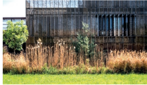
Lycée Le Corbusier, BFT Architectes, 2012 © Lycée Le Corbusier
