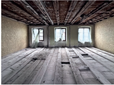
Curage – mairie d'Ingersheim © CRUPI architectes
