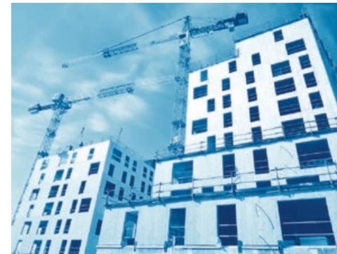
Chantier du bâtiment «Sensations» © KOZ Architectes-ASP Architecture
