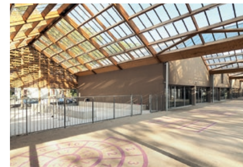
Transformation du groupe scolaire Gustave Doré, TOA architectes associés © TOA architectes associés
