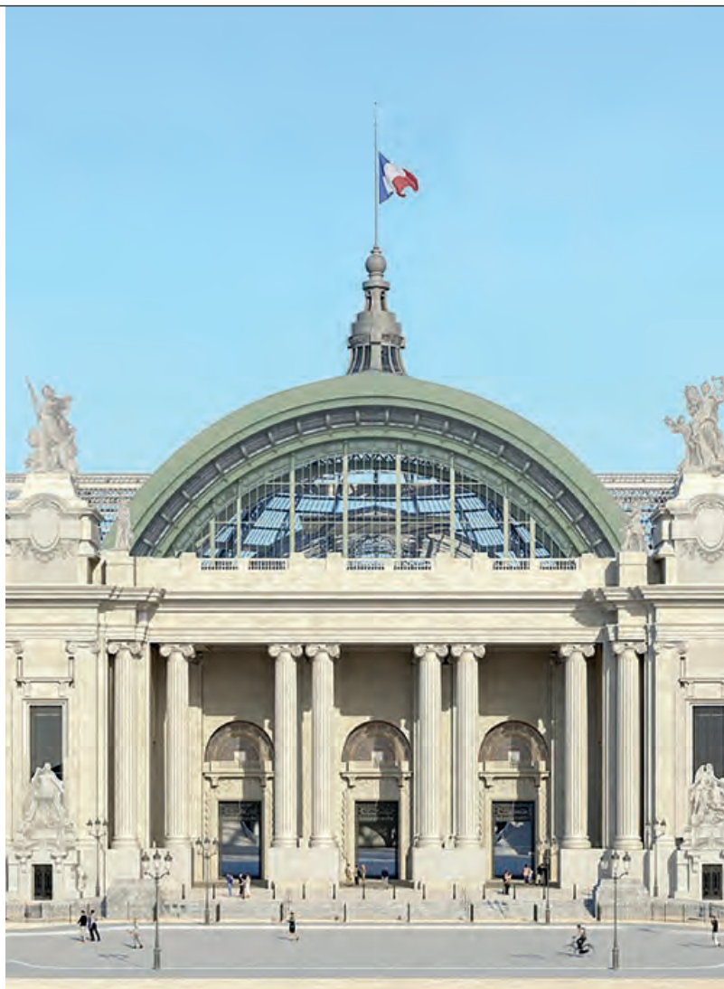
Grand Palais, Paris Maîtrise d'œuvre technique, structure, fluides, synthèse d'exécution © Chatillon Architectes pour la Rmn – Grand Palais
