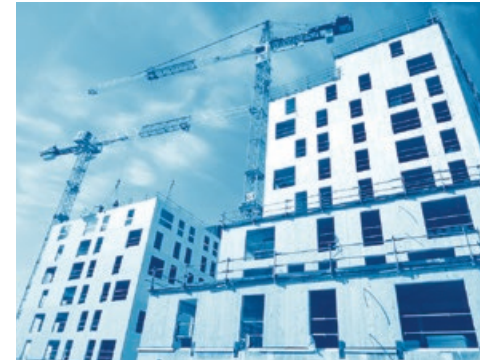
Chantier du bâtiment «Sensations» © KOZ Architectes-ASP Architecture
