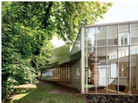
Salle de conférence, réhabilitation Villa, rénovation énergétique, Rey-de-Crécy atelier d'architecture © Rey-de Crécly atelier d'architecture
