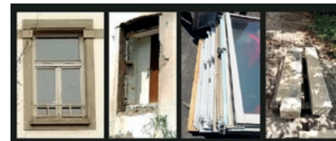
Déconstruction sélective © nunc architectes
