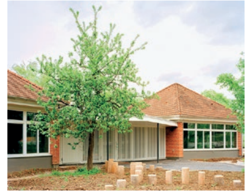
Schulanlage Gellert – Thomas Thalhofer, Architekt von MET Architects © Piotr Hrapovich
