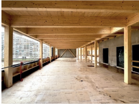
Structure bois dans les futures salles de classe © buob architecte
