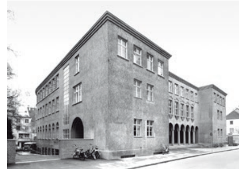
Arbeitsamt historisches Bild - Platzhalterbild Julius Maurizio, 1953, MET Architects 2024 © Piotr Hrapovich
