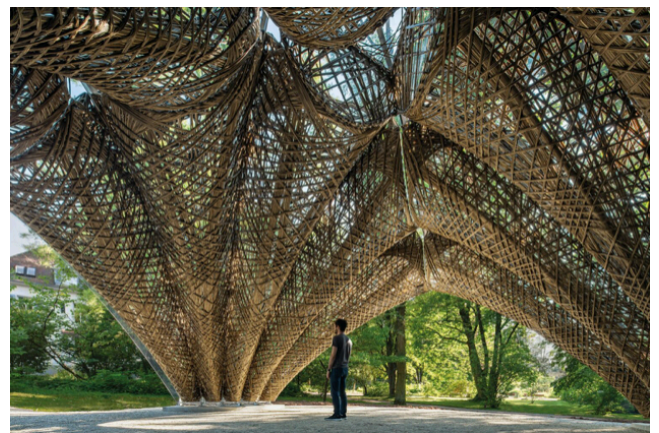
Pavillon « livMatS » avec structure porteuse en fibres de lin - Institut ICD et ITKE de Stuttgart
